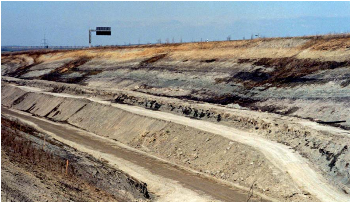
Abb. 14.13 Erfurt-Formation nahe der Typlokalität. Einschnitt der ICE-Trasse im Bereich des Hauptlettenkohlsandsteins S2 bis Sandstein S3 nördlich der Brücke an der Ausfahrt Arnstadt Nord der A 71. Foto WERNEBURG 2003.
